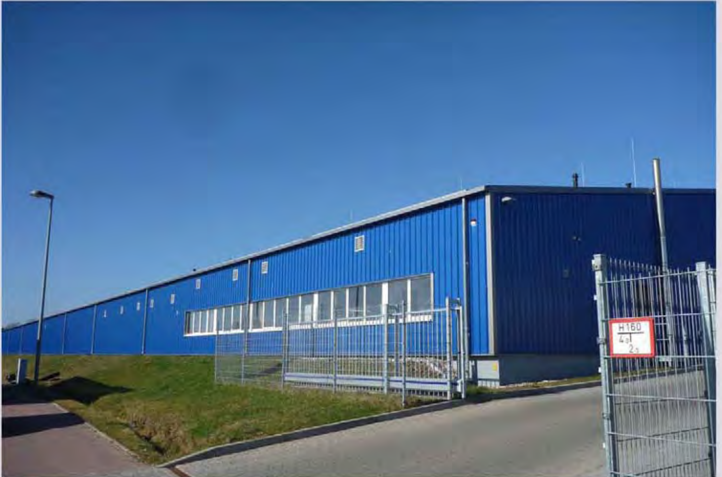
Baubetriebshof der Stadt Bad Oldesloe Neubau 2011
